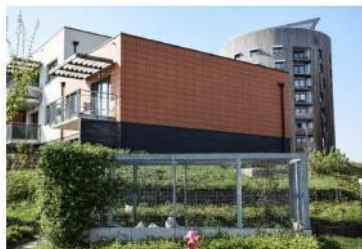
La Louvière Dans la 'Cité des Jardins', les déchets ménagers sont triés et recyclés : poubelles à compartiments dans les cuisines, lieux de stockage au pied des bâtiments, compost... Des ateliers de réparation et des magasins de seconde main sont également proposés.
